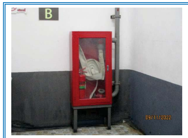
รูปที่ 3-40 ตู้เก็บสายฉีดน้ำดับเพลิงและหน้ากากป้องกันควันไฟในห้องพัก
