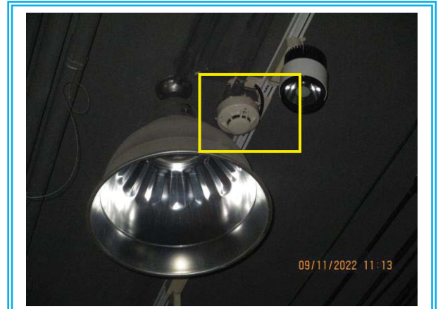
รูปที่ 2.11-2 เครื่องตรวจจับควันและความร้อน Tower C2
